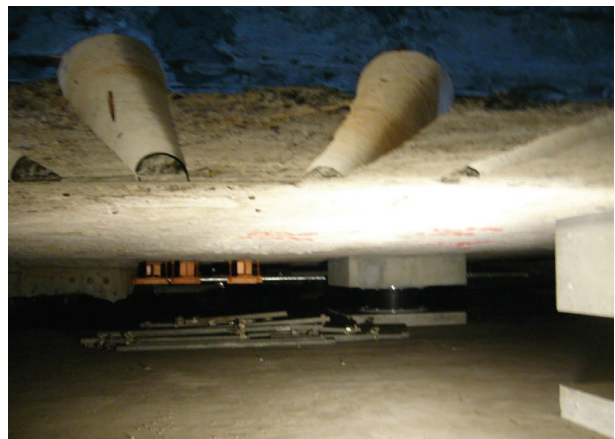
Figura 4 | Le Corbusier, Museu Nacional de Arte Ocidental, Parque Ueno, Tóquio, Japão, 1959. Reforço Sísmico, 2008. Fonte: Ana Tostões, 2012
