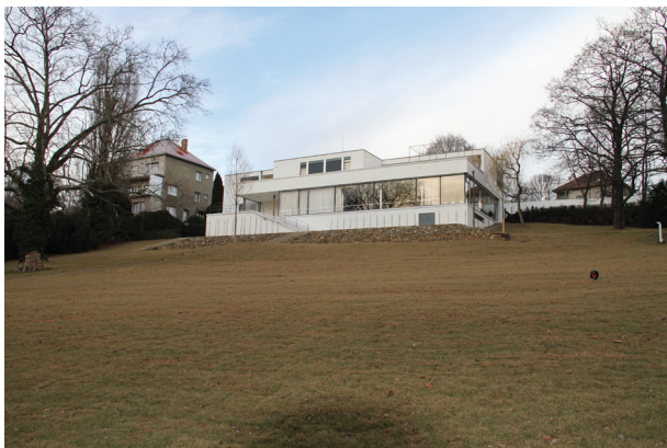
Figura 1 | Mies van der Rohe e Lilly Reich, Casa Tugendhat, Brno, República Checa, 1929-30. Após o restauro. Fonte: Ana Tostões, 2012
