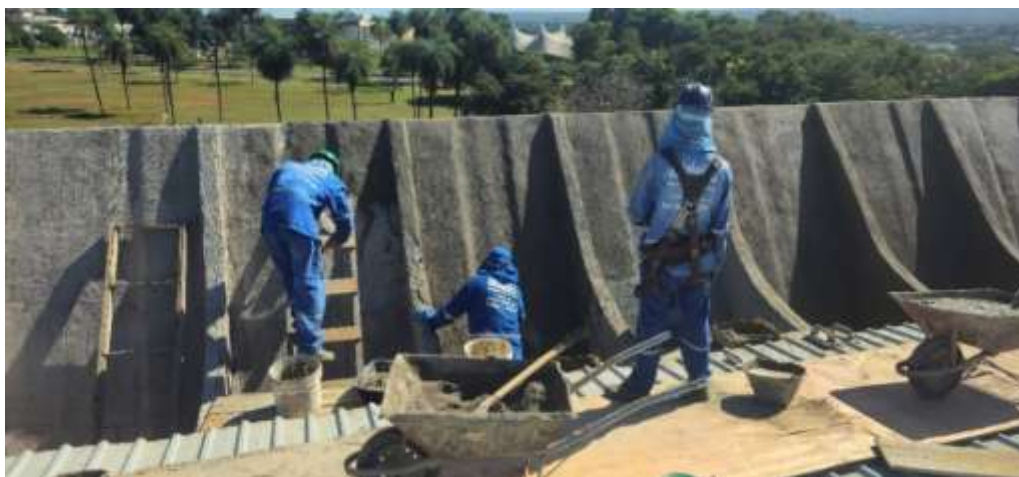
Figura 12: Aplicação de proteção mecânica com tela plástica sobre a estrutura da cobertura norte.
