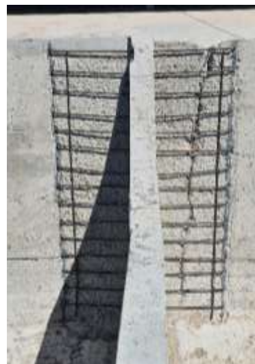
Figura 17: Detalhe da execução de reparo de fissura na laje de cobertura.
