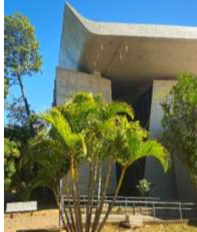
Figura 8: Brises e cobertura da fachada sudeste, após intervenção em 2025.
