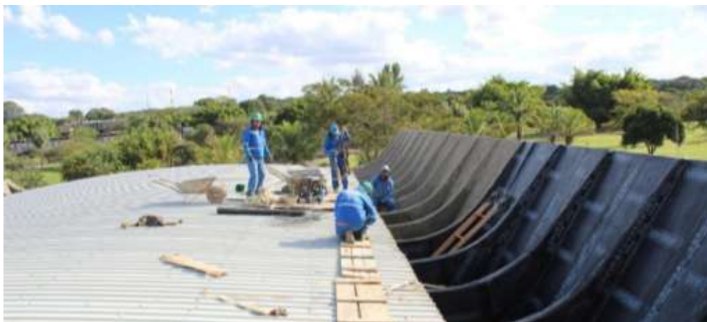
Figura 11: Aplicação de manta asfáltica e proteção mecânica sobre a estrutura da cobertura norte.
