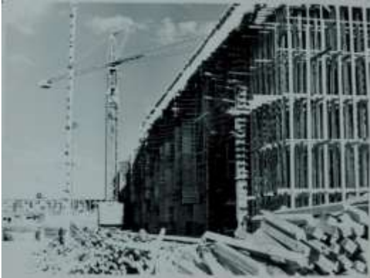
Figura 7: Montagem das formas de madeira para concretagem dos brises e cobertura da fachada sudeste em 18 de fevereiro de 1971.
