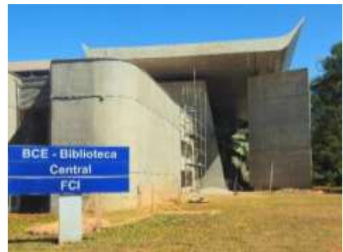
Figura 6: Brises e cobertura noroeste, após intervenção em 2025.
