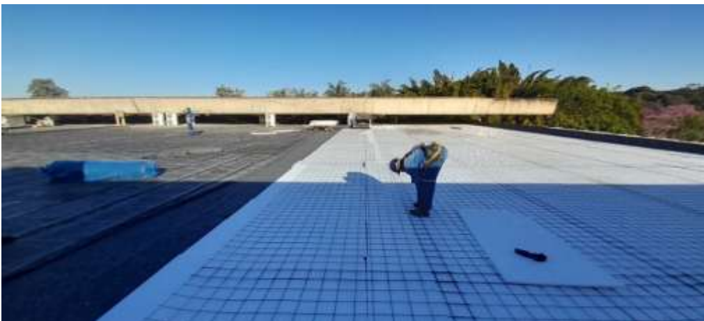
Fonte: Acervo da Diretoria de Obras, 2024.
