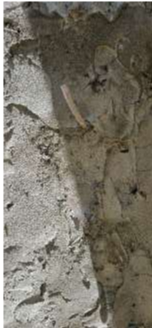
Figura 14: Detalhe do reparo com o bico de injeção de resina.
