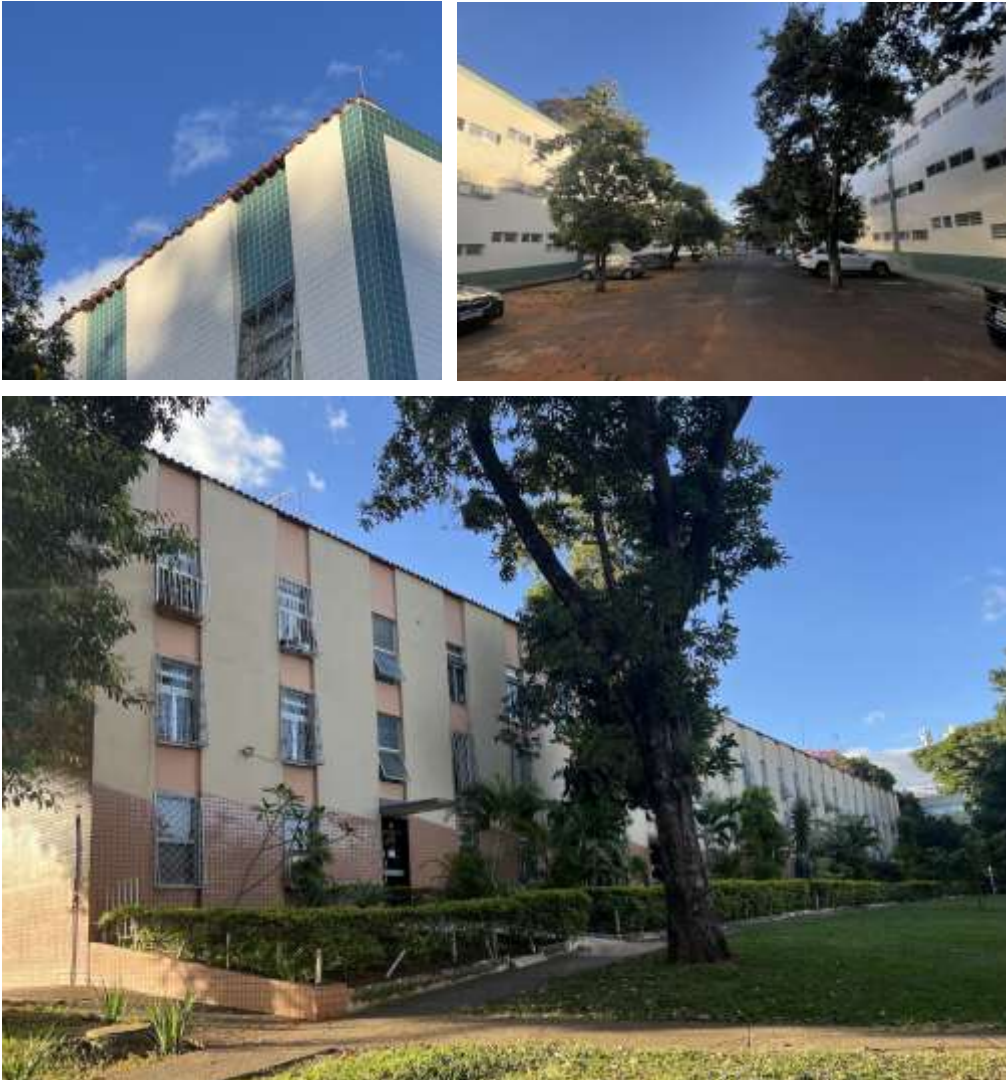
Figura 10 – Condições atuais dos Blocos JK.
