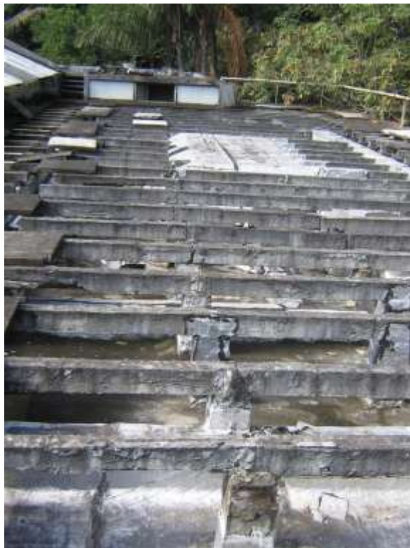
Figura 9: foto da laje de cobertura em 2008 (16/07/2008).
