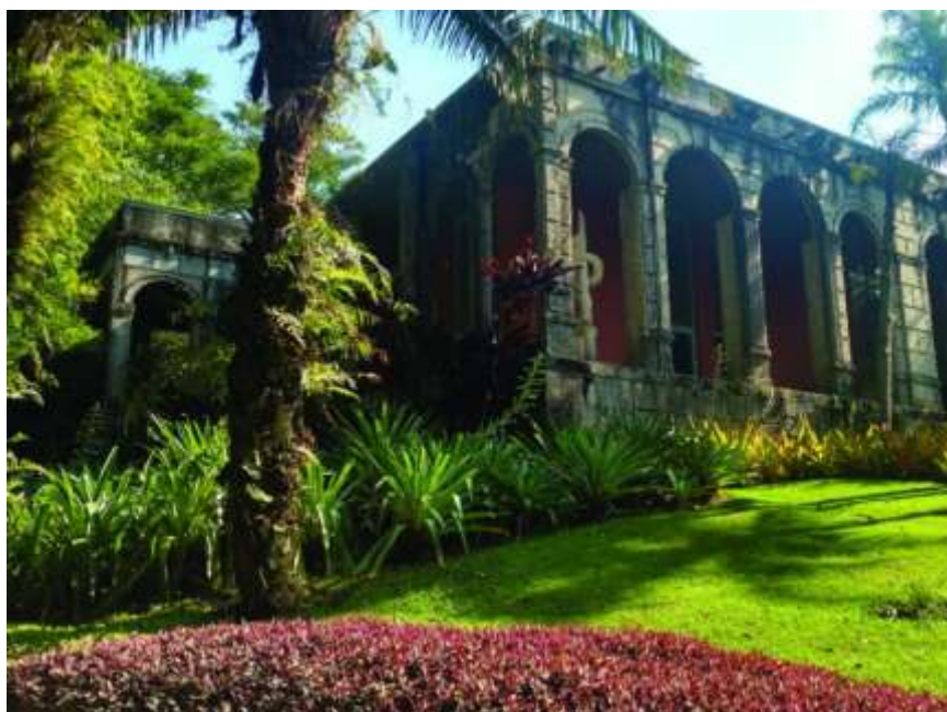
Figura 2: Foto externa da fachada norte
