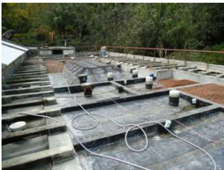
Figura 12: foto da laje de cobertura em 2011: execução do projeto Cetimper.
