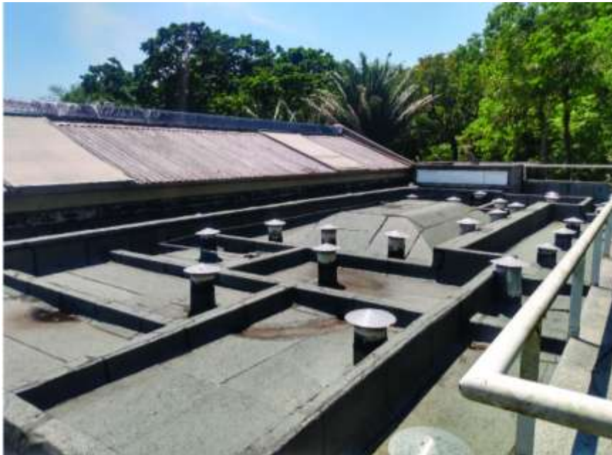
Figura 6: Foto da laje de cobertura.
